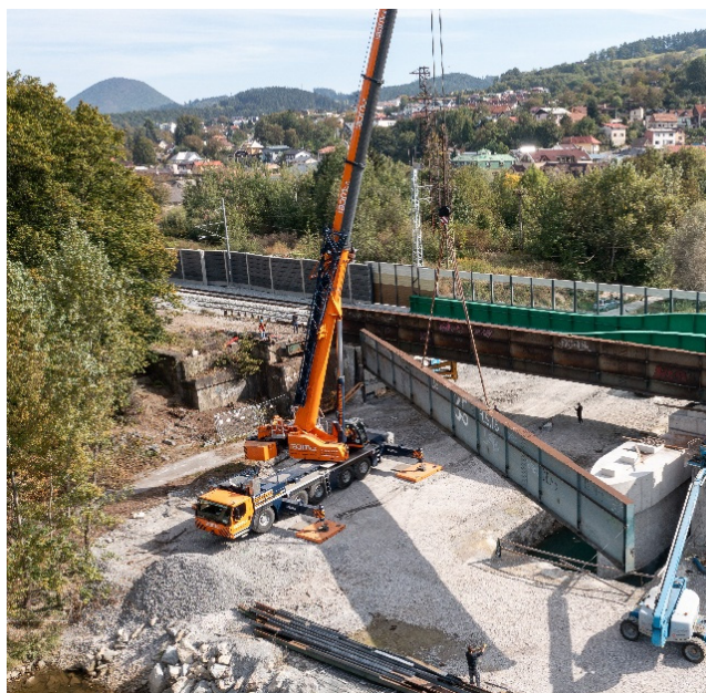
Obr. 10 Demontáž starej ocelevej konštrukcie v II. etape
