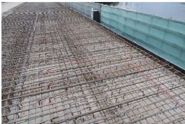
Obr. 2 Kotvení z betonářské výztuže
