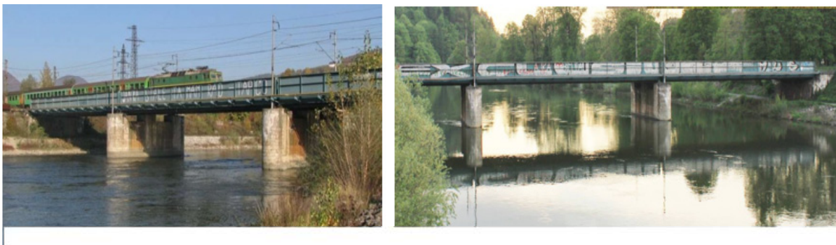
Obr. 1 Pôvodný stav železničných mostov
