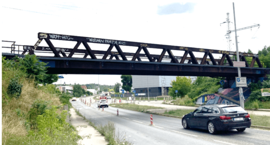
Obr. 3: Železniční most Brno - Komárov
