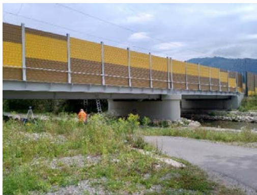
Obr. 9. Pohľad na most
