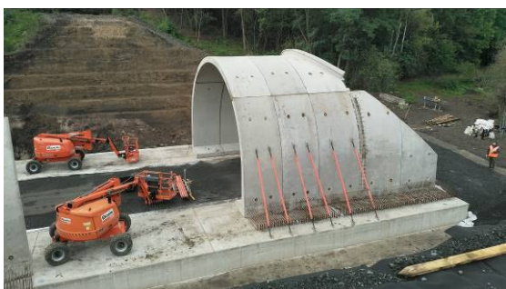
Obr. 2: Rekonstrukce mostu v km 190,152 trati Plzeň – Žatec
