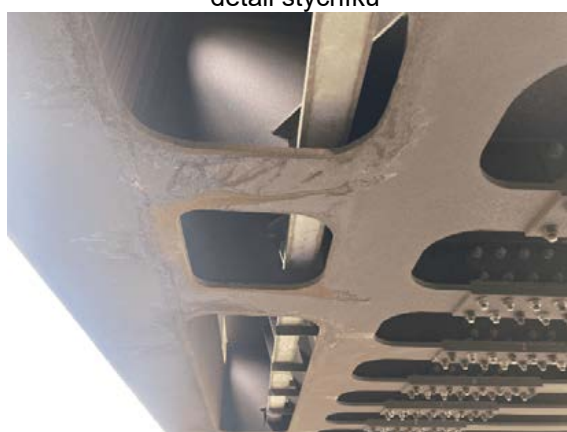
spodní pásnice hlavního nosníku a příčníků
