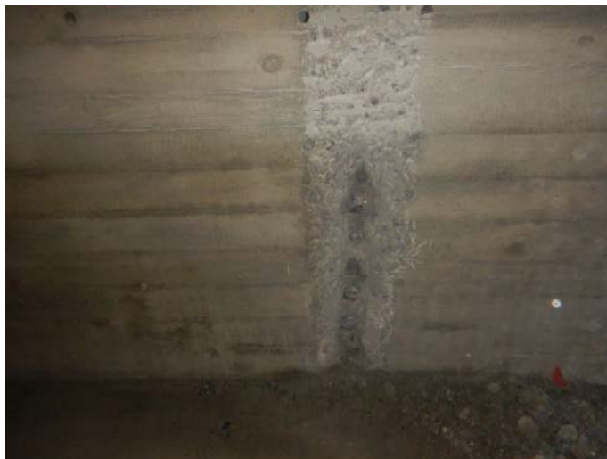
Obr. 1: Odkryté kabely předpínací výztuže v místě budoucího deviátoru.
