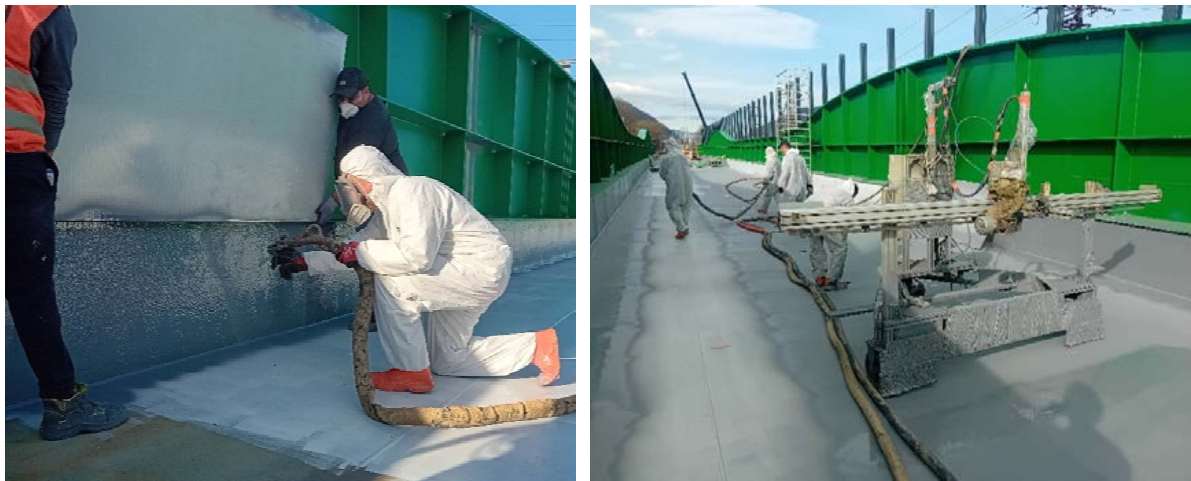
Obr. 16 Aplikácia izolácie mostovkovej vane
