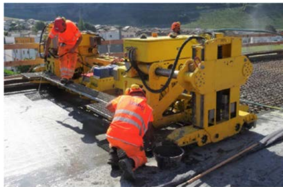
Obr. 5 Pokládka UHPC finišerem [9]
