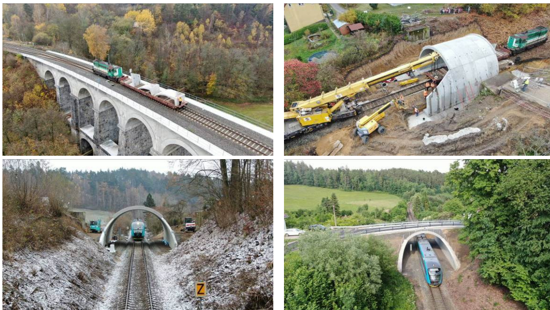
Obr. 4: Most v obci Sychrov – Radostín přes železniční trať 030
