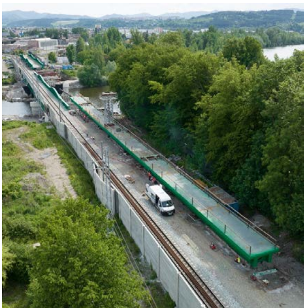
Obr. 17 OK lávky na montážnej plošine
