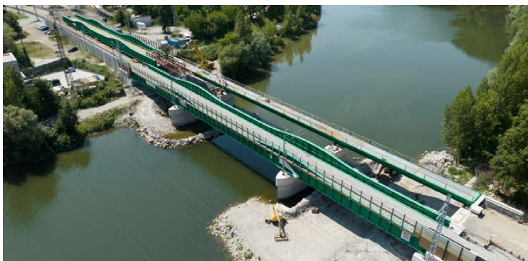
Obr. 19 – Lávka osadená na pozícii
