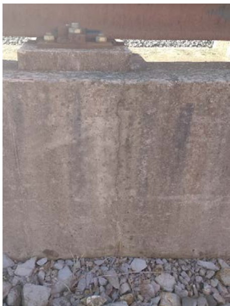
Obr. 7. Trhlina v betóne – severná strana
