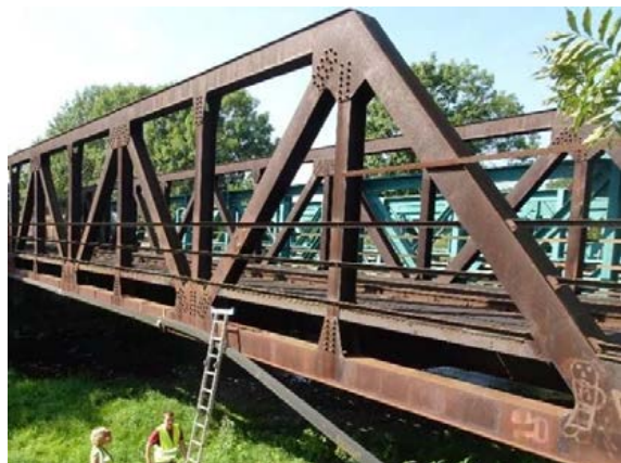
celkový pohled na most
