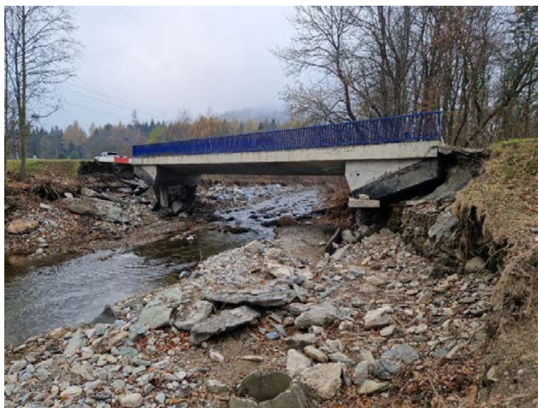
Obr. 5: Pohled na most proti směru toku
