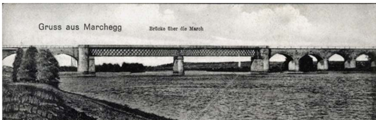
Obr. 2: Most cez rieku Morava, archívne foto
