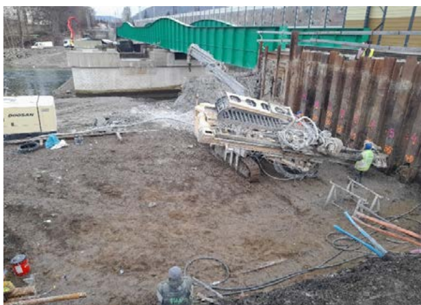
Obr. 9 Paženie stavebných jám opôr
