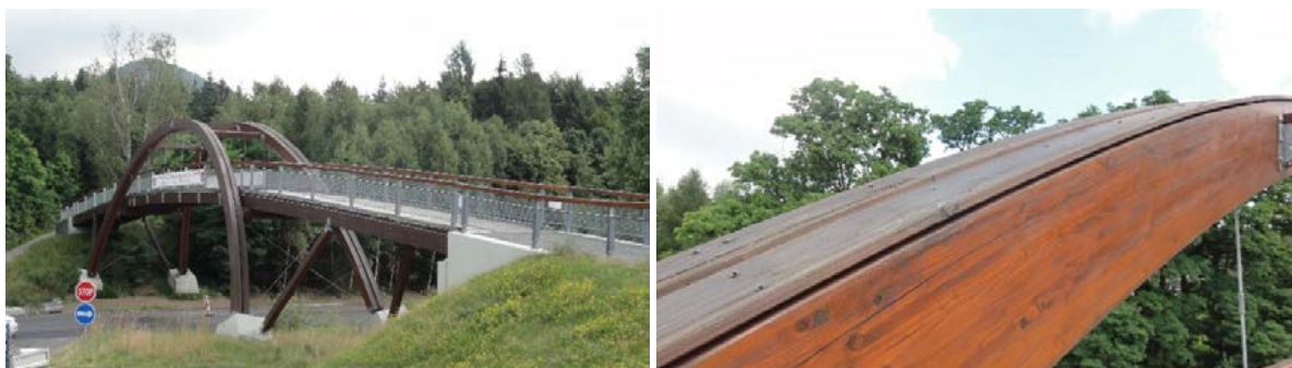
Obr. 8: Dřevěná konstrukční ochrana horní hrany nosného oblouku dřevěné lávky v České republice.
