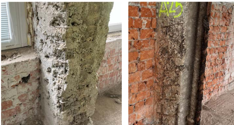
Obr. 5 Fotografia železobetónových stĺpov po odstránení omietky – kvalita povrchu po betonáži
