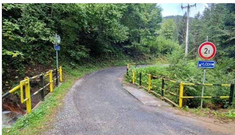
Obr. 8: Pohled řidiče na mostě bez viditelných známek poškození
