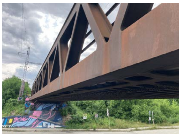
celkový pohled na most
