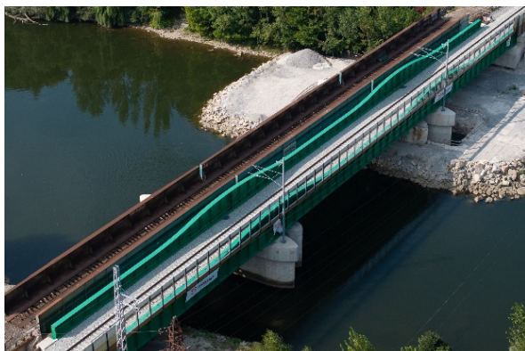
Obr. 20 Dokončenie I. etapy rekonštrukcie
