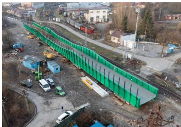
Obr. 14 Zmontovaná oceľová konštrukcia v I. etape
