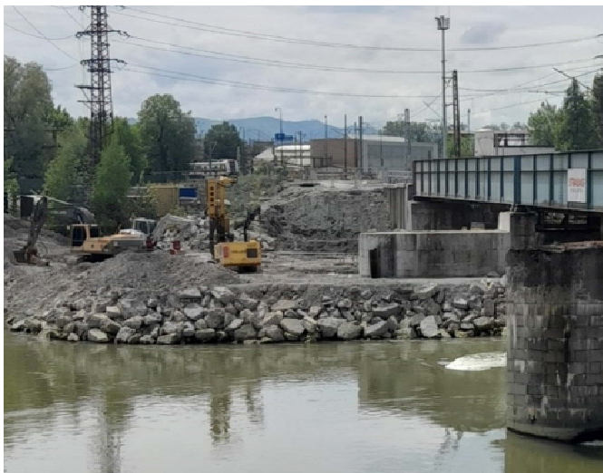
Obr. 7 Presyp koryta rieky (pracovná plošina)
