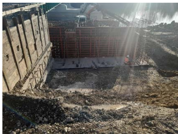
Obr. 9 Paženie stavebných jám opôr
