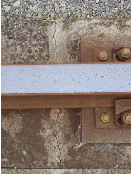
Obr. 5. Trhlina v betóne – južná strana
