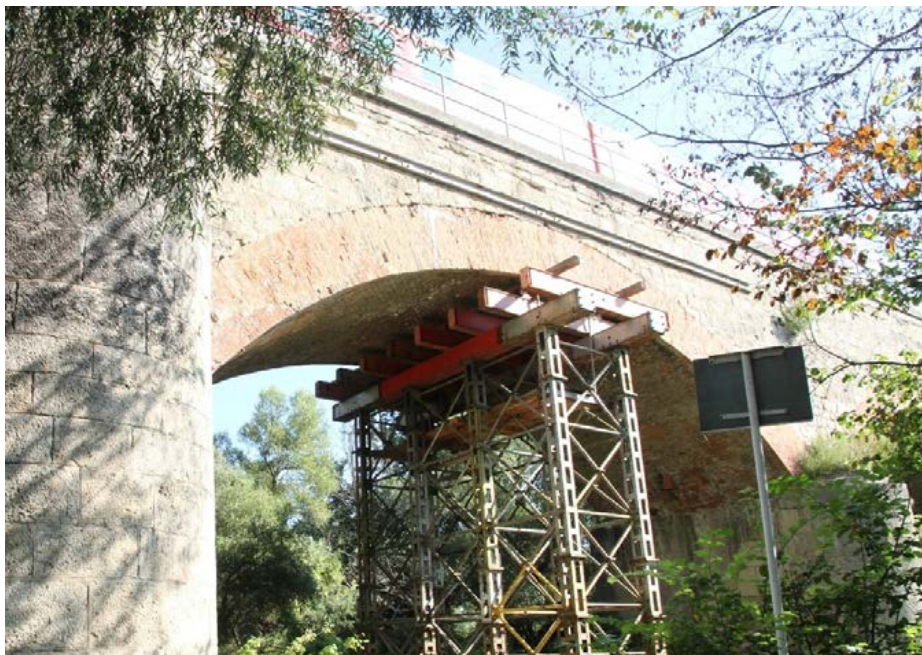
Obr. 3: Provizórne podopretie klenby č. 1
