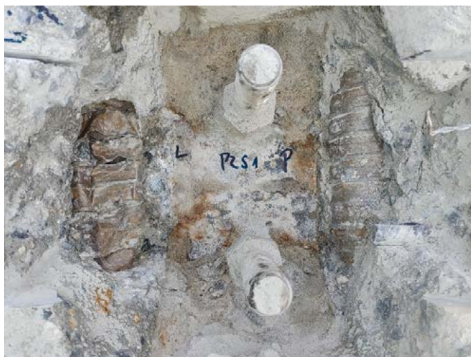
Obr. 2: Sonda k předpínací výztuži z horního líce mostovky.
