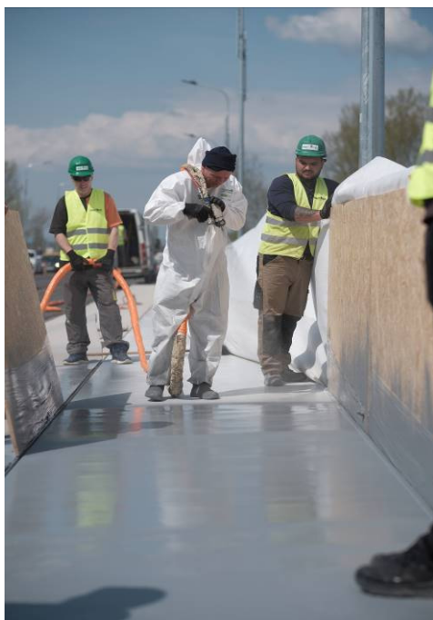
Obr. 6: Aplikácia PURTOP 1000N na cyklochodníku, Most Hlohovec
