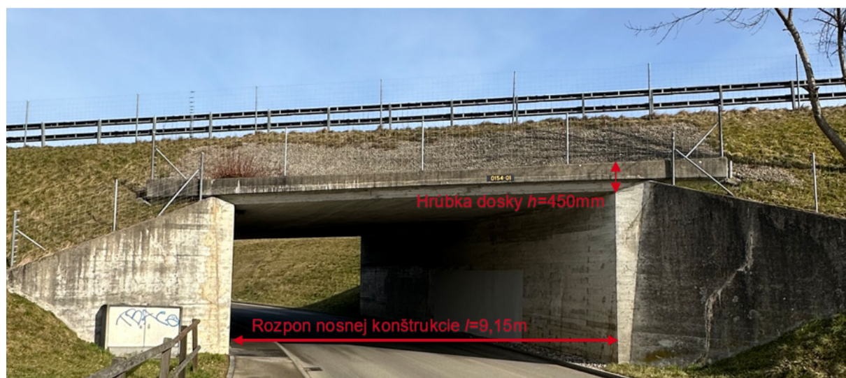
Obr. 5: Bočný pohľad na rámový diaľničný most 0154-01, Švajčiarsko [5].
