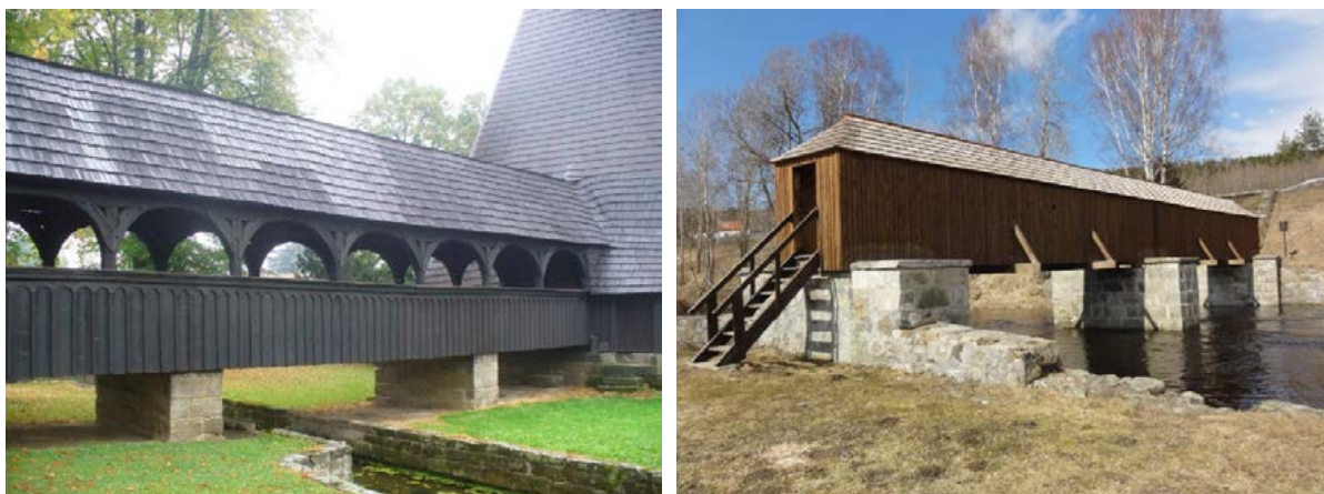
Obr. 1: Lávka Kočí u Chrudimi (1721, L = 18 m) (vlevo), Lávka Lenora (1870, L = 27,77 m) (vpravo).
