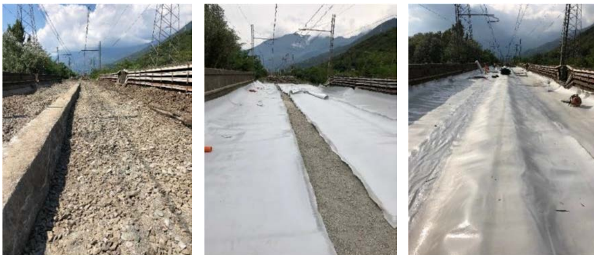
Obr. 4: Aplikácia PURTOP 1000 na železničnom moste – postup prác
