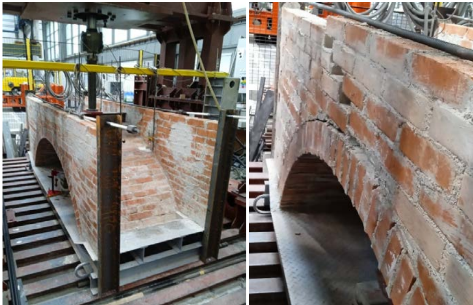
Obr. 13: Zaťažovanie a porušenie experimentálnej vzorky murovanej klenby s bočnou stenkou.
