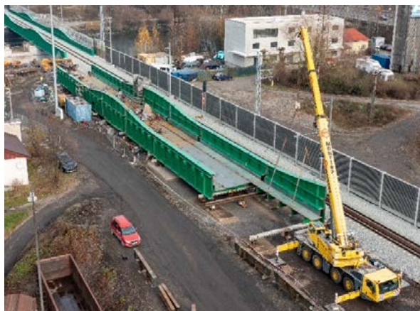
Obr. 13 Montáž ocelevej konštrukcie v II. etape
