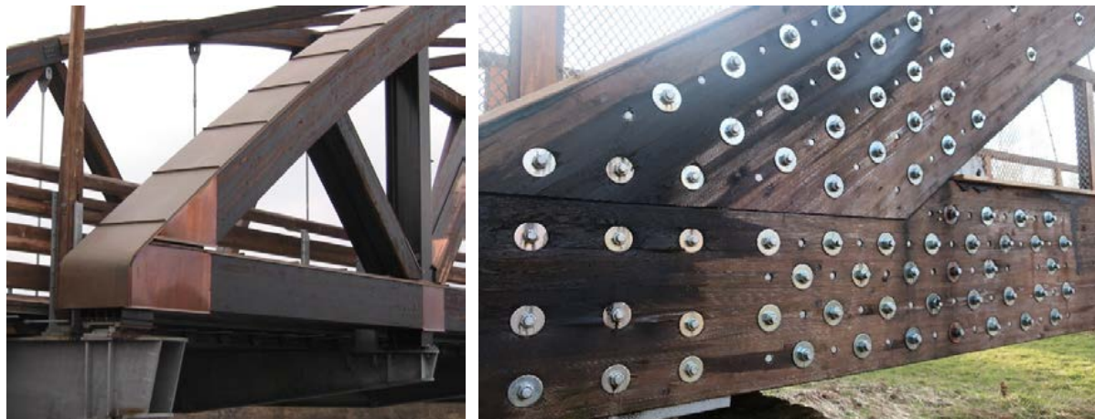
Obr. 7: Různé přístupy ke konstrukční ochraně nosných prvků mostů v Norsku (vlevo) a v České republice (vpravo).
