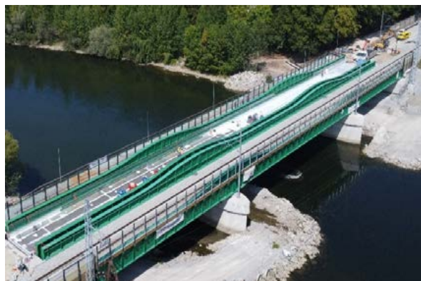
Obr. 21 II. etapa – dokončovacie práce
