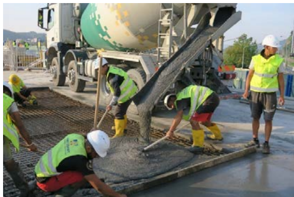
Obr. 4 Ruční pokládka UHPC
