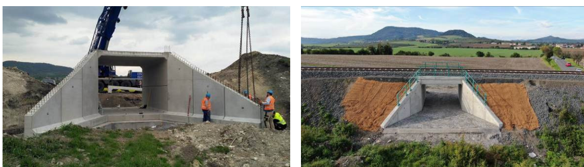
Obr. 5: Revitalizace trati Lovosice – Česká Lípa, železniční most v ev. km 50,058
