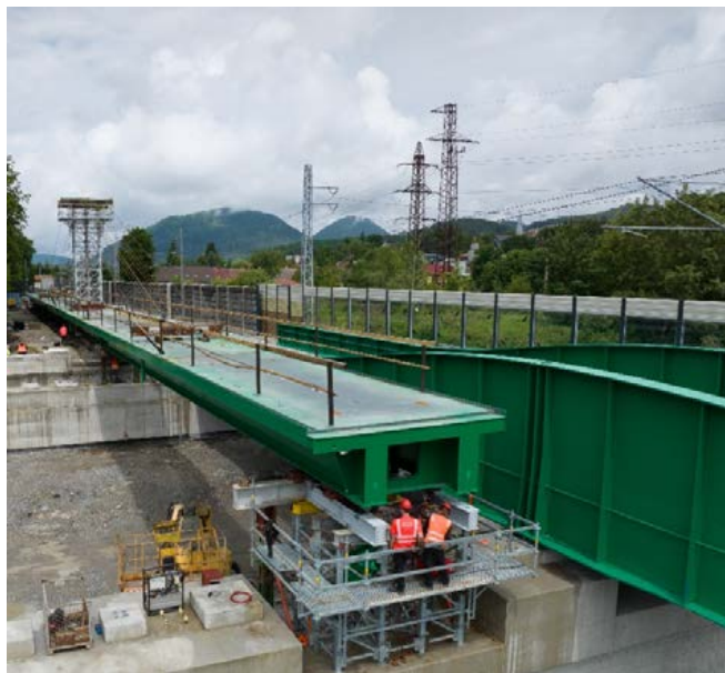
Obr. 18 Výsuv OK lávky
