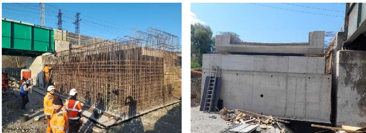
Obr. 6 Realizácia opôr
