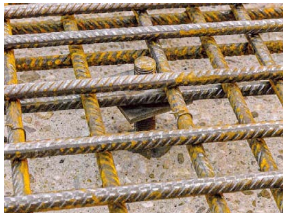
Obr. 3 Kotvení ze závitové tyče (dle [8])
