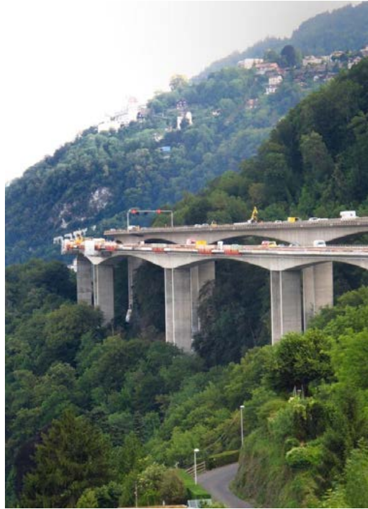
Fig. 1: Chillon Viaduct (© XBau AG)
