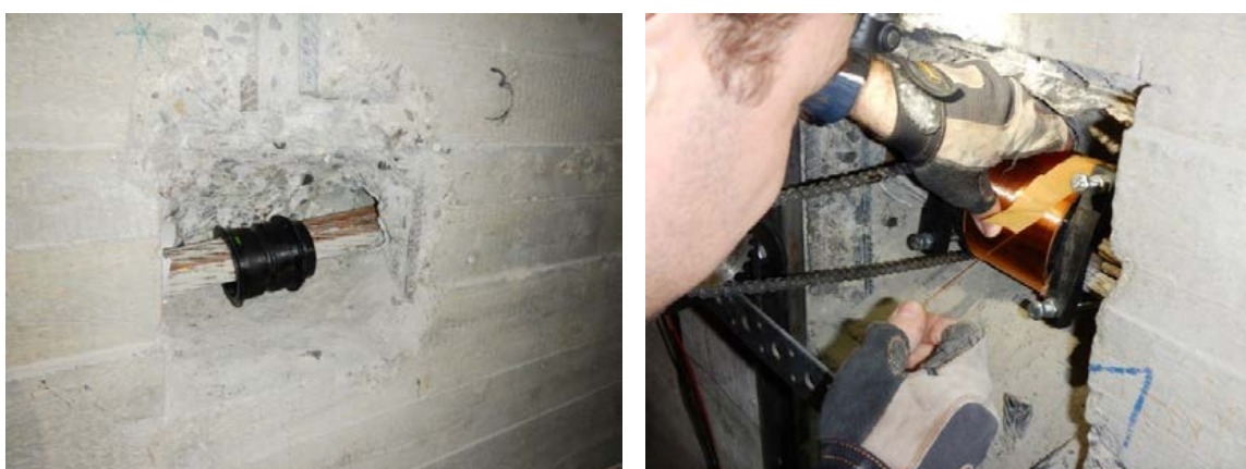
Obr. 6: Vlevo: Kostra EM snímače na stávajícím kabelu. Vpravo: Navíjení vinutí snímače.
