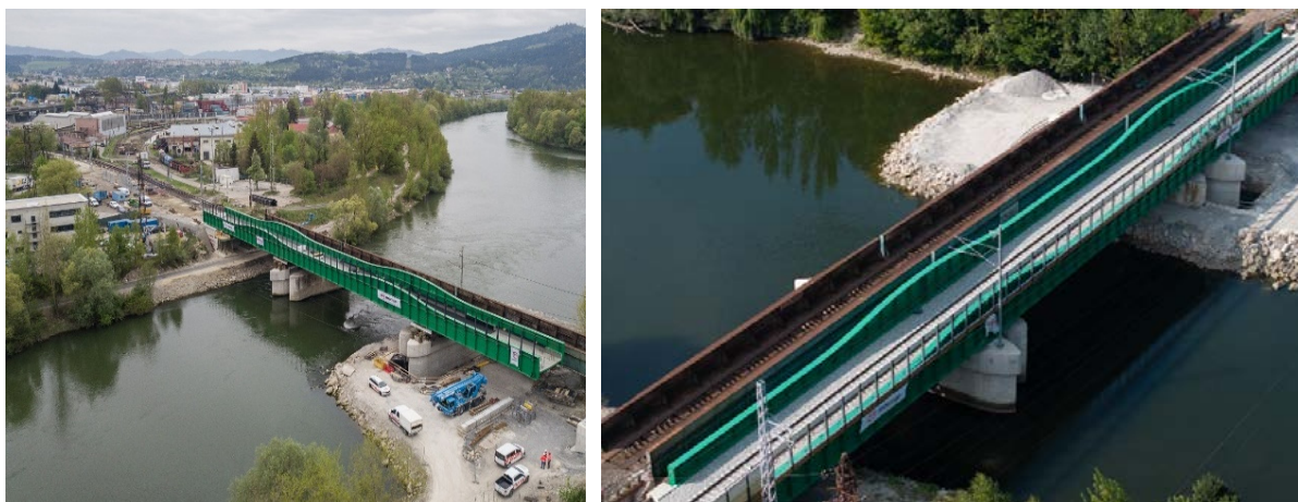
Obr. 3 Rekonštrukcia mostov I. etapa
