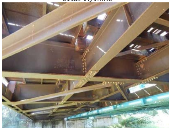
podélníky a příčnice mostovky
