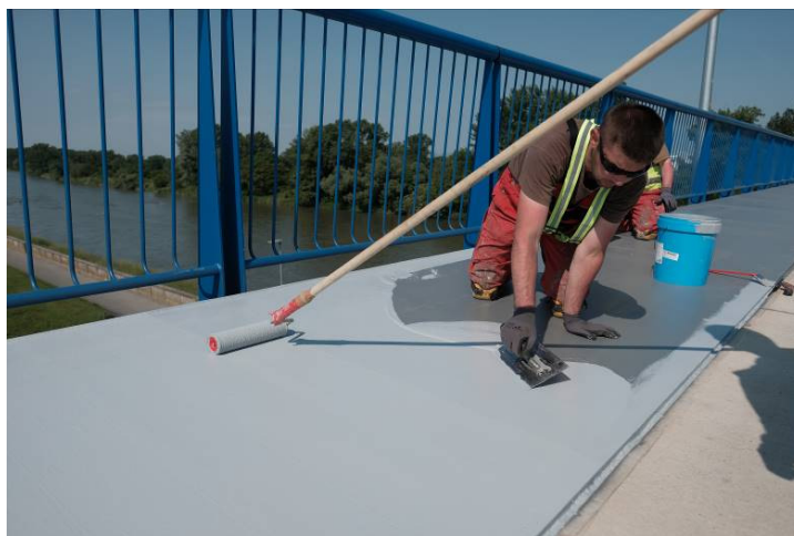
Obr. 7: Aplikácia protišmykového a UV stabilného finálneho náteru Mapecoat TNS Race Track
