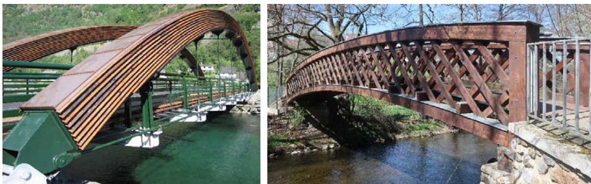
Obr. 6: Příklady konstrukční ochrany dřevěných mostů z Norska (vlevo) a České republiky (vpravo).
