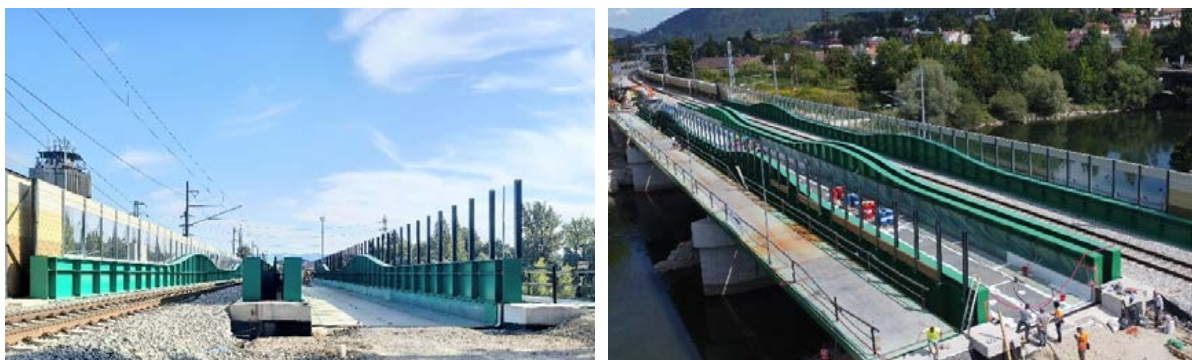
Obr. 5 Rekonštrukcia mostov II. etapa
