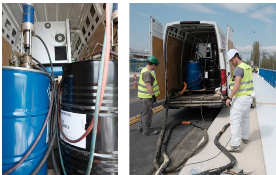
Obr. 3: Príklad integrácie striekacieho zariadenia materiálu do vozidla
